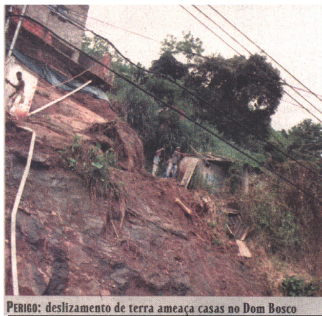
Fig. 06: Deslizamento de terra no Bairro Dom Bosco ocorrido na madrugada do dia 31 de janeiro de 2003 (TRIBUNA DE MINAS, 2003)
